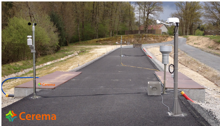
Figure: Le démonstrateur d'Egletons
